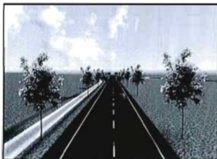
Panorë e Segmentit Tepelenë-Gjirokastrë pas rehabilitimit
